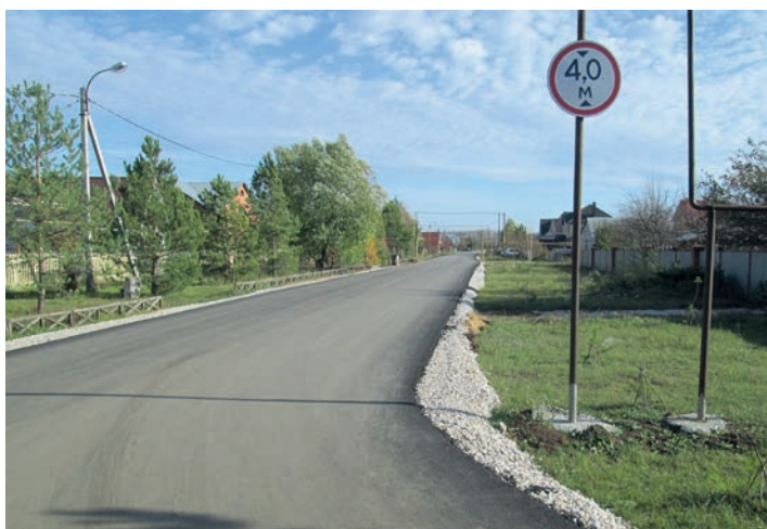
Ремонт ул. Центральная, с. Красный Яр
