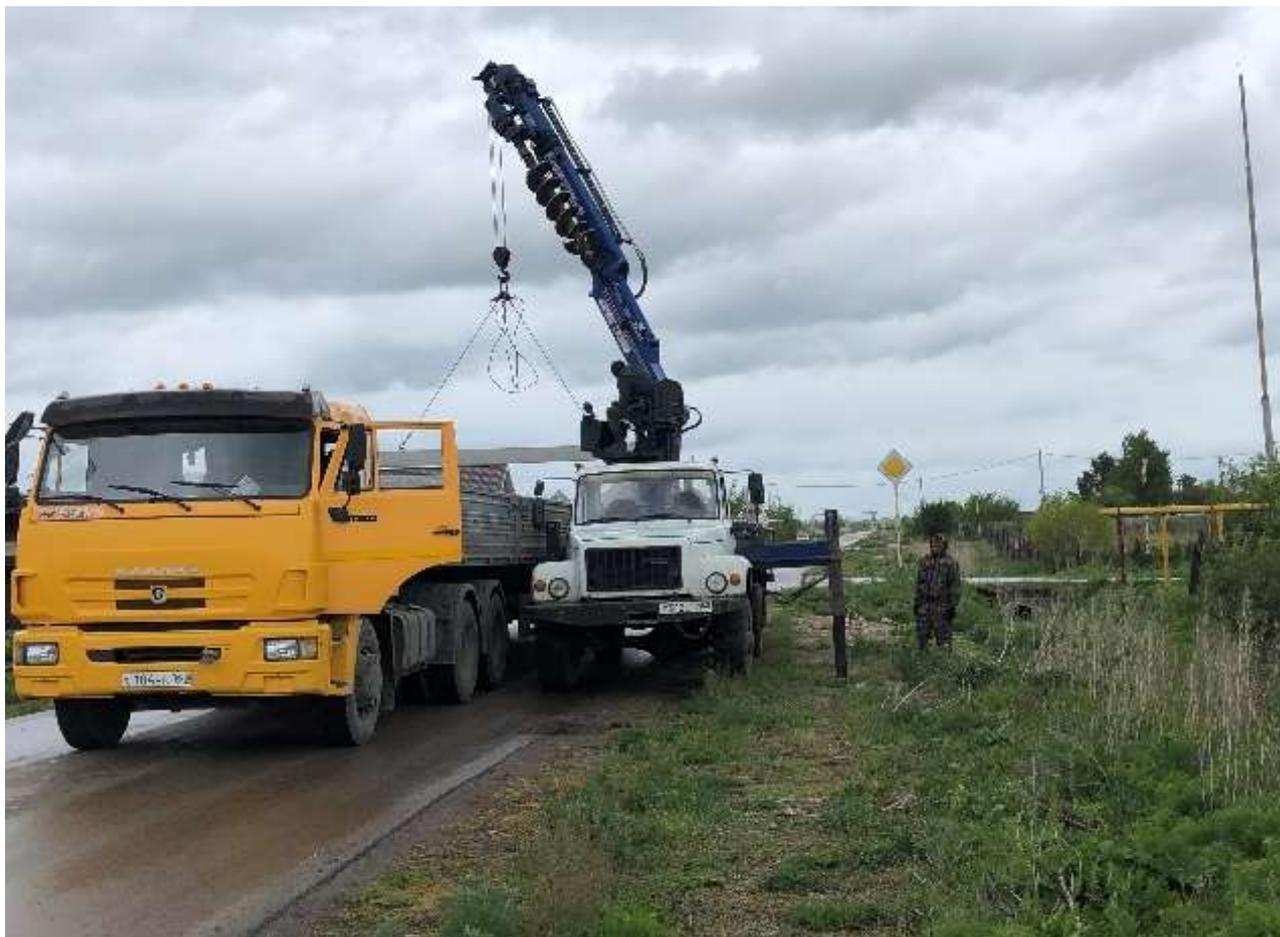
**Выполнен капитальный ремонт наружного освещения улицы Никонова от дома № 42 до автодороги "УРАЛ" в селе Белозёрки на сумму 838,1 тыс. руб.. Смонтировано 385 м воздушной линии мощностью 0,23 кВ, установлено 23 осветительных прибора. Общая электрическая нагрузка составила 1,4 кВт.**
