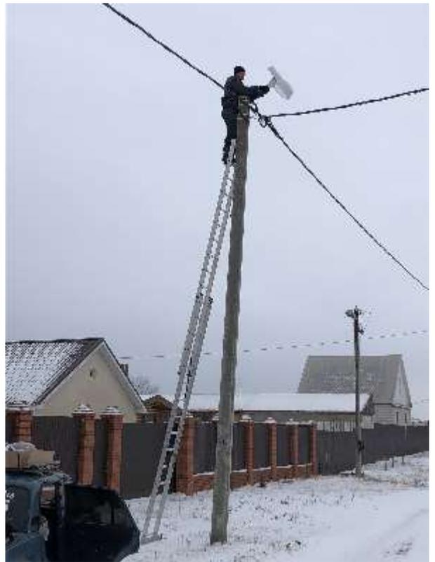
протяжённостью 396м. Смонтировано светильников-5 шт. Линия наружного освещения работает в автоматическом режиме.
