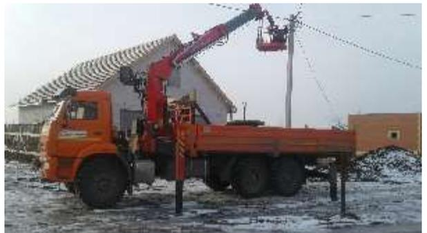
10. Выполнено строительство линии уличного освещения по адресу: село Красный Яр, улица Рябиновая от уч. №18 до уч. №36. Смонтировано 3 осветительных прибора. Линия наружного освещения работает в автоматическом режиме.
