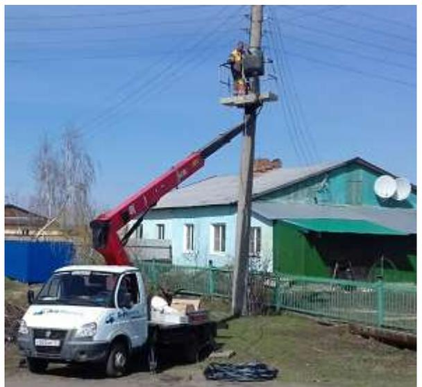
18. Выполнено строительство линии наружного освещения по адресу: село Нижняя Солонцовка ул. Речная от от уч.№18 до уч. №21. Выполнен подвес провода протяжённостью 160м, смонтировано светильников-2 шт. Линия наружного освещения работает в автоматическом режиме.
