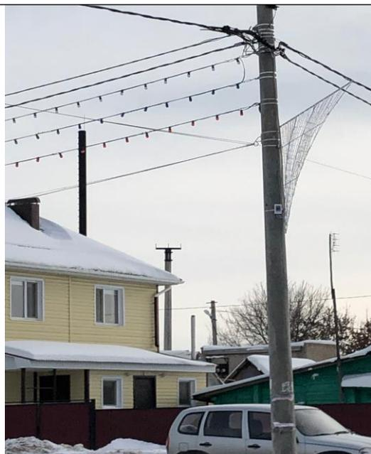
15. В с. Красный Яр, на ул. Советская, от дома № 13 до дома № 35 в декабре сетевая компания смонтировала новую магистраль и переключила абонентов на данную ВЛ. Совместными силами был произведён демонтаж старой линии и переключение линии уличного освещения.
